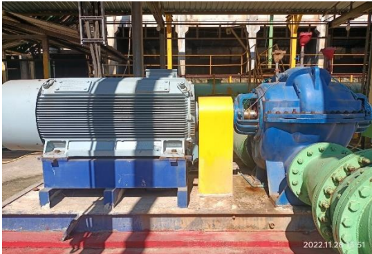
รูปที่ 33 การปิดครอบอุปกรณ์เครื่องจักร
