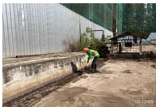
รูปที่ 30 การขุดลอก รางระบายรอบลานกองเก็บเชื้อเพลิง
