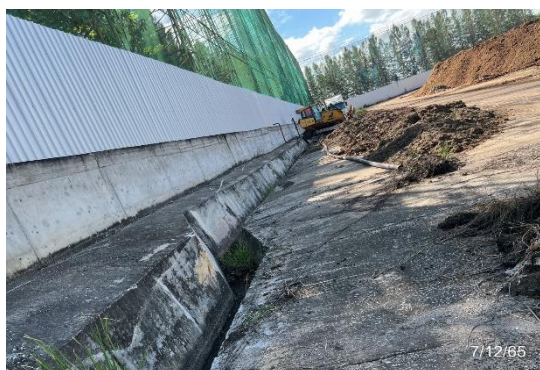
รูปที่ 17 รางระบายรอบลานกองเก็บเชื้อเพลิง
