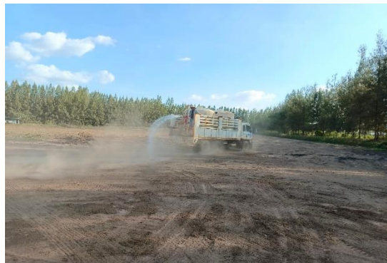
รูปที่ 21 การฉีดพรมน้ำบริเวณลานกองเถ้า
