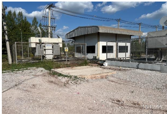
รูปที่ 37 บ่อแยกน้ำและน้ำมัน บริเวณสถานีไฟฟ้า (Switch Yard)
