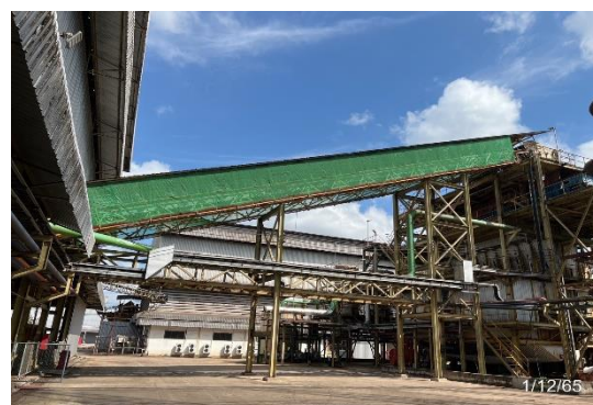
รูปที่ 6 ระบบสายพานลำเลียงกากอ้อยแบบปิด
